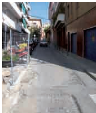
9.- Asfaltat del carrer d'En Riera 17.000 euros
