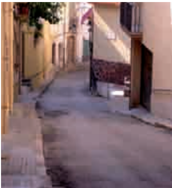
11.- Pavimentació del carrer de l'Olivar 20.000 euros
