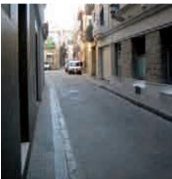
15.- Enderroc de voreres i pavimentació al carrer Bisbe Català 132.750 euros
