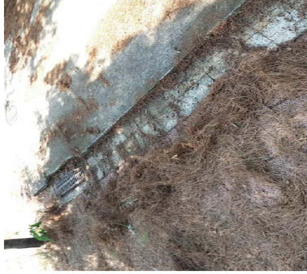
17. Calçada urbanització Montnar
