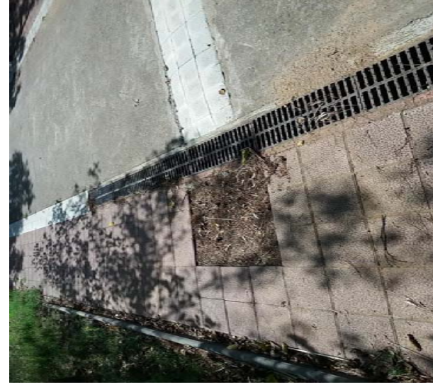
15. Urbanització Montmar (escocells)
