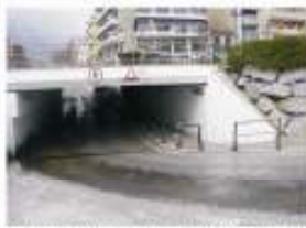
18. Renovació de les benanes del túnel per anar a la platja i de l'ascensor. 7.000 €.
