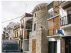
14. Retolació dels edificis emblemàtics de la vila. 8.000 €.
